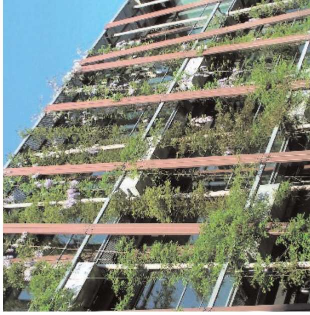
An den Fassaden des Institutsgebäudes für Physik der Humboldt-Universität in Berlin-Adlershof wachsen Kletterpflanzen als Schattenspender vor den großen Glasfenstern.
